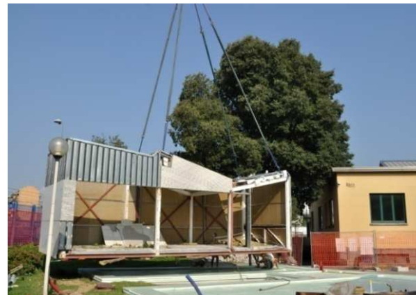
VeluxLAB: inizio del cantiere
